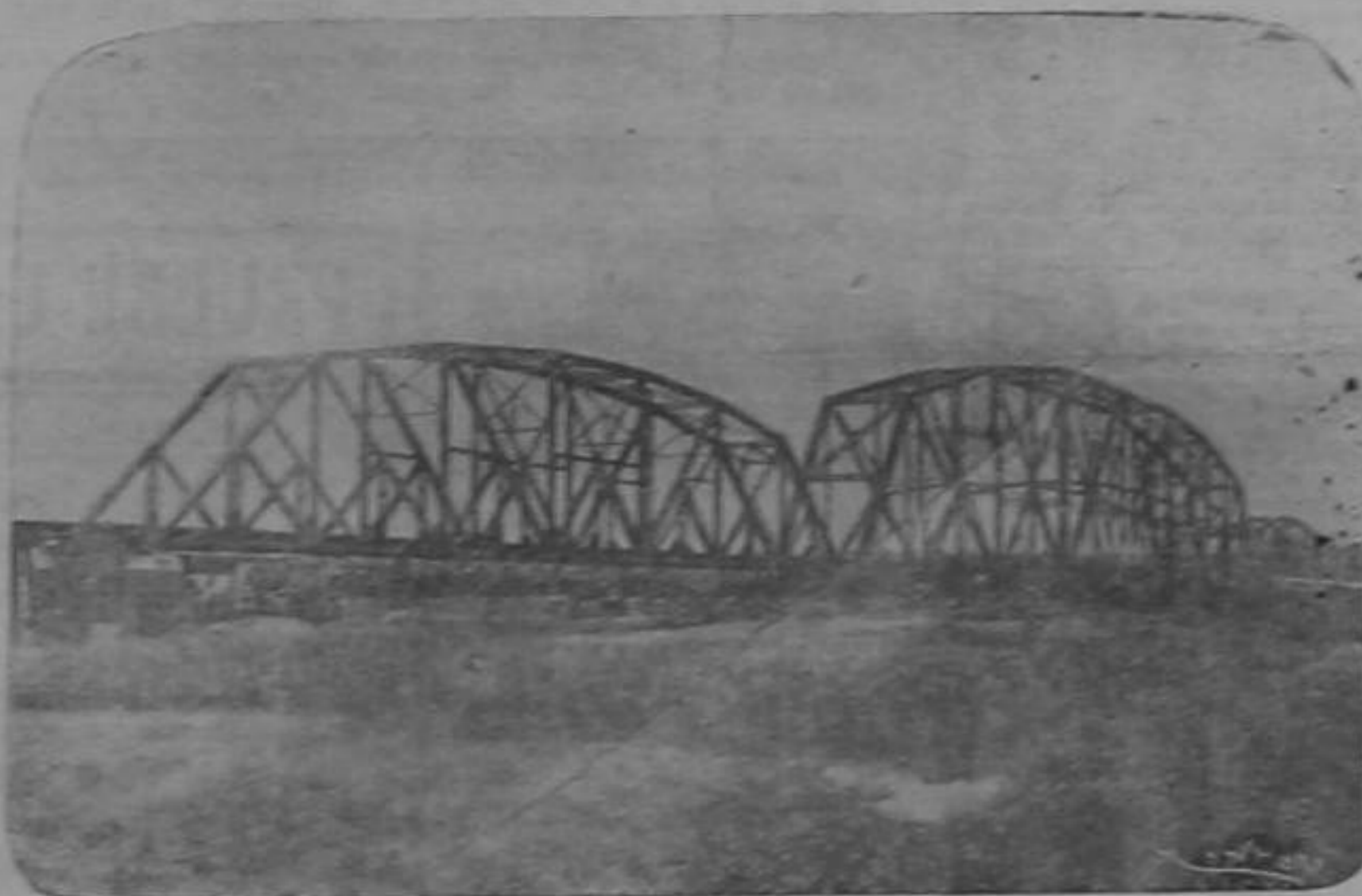
El llamado Puente Internacional, extendido sobre el Río Sixaola, y que une a Costa Rica con Panamá, consta de tres grandes arcos de hierro, y mide doscientos cincuenta metros de largo.
